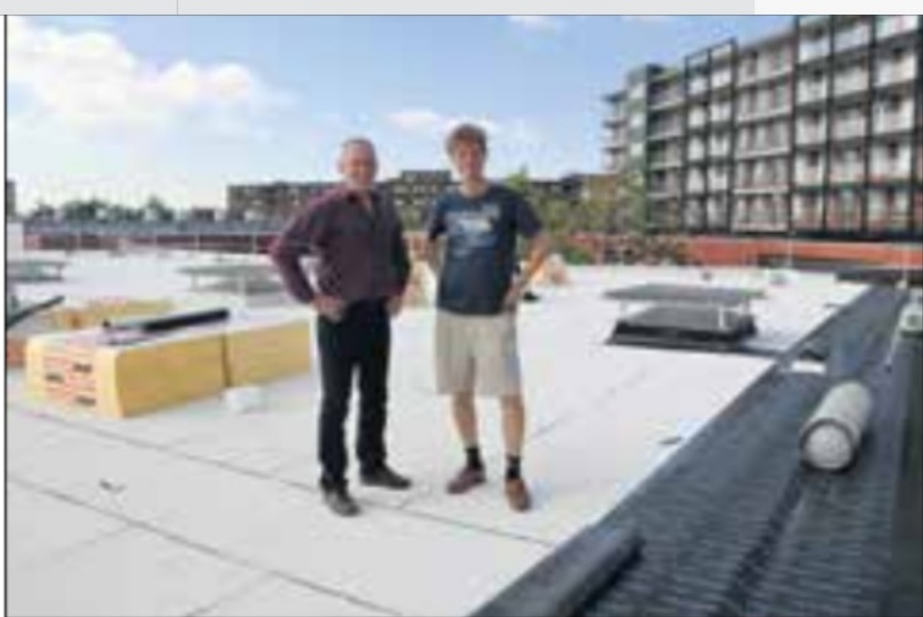
De Leeuw en Aarts op het witte dak (rechts nog zwart dak).
